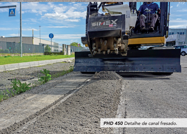
PLB 300. Remoção da camada de asfalto numa obra de uma estrada
