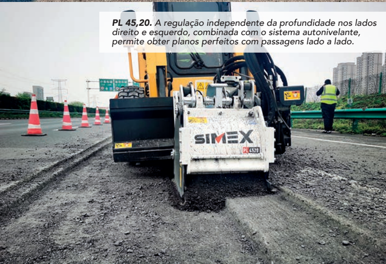
PL 2000. Escarificação do tapete de desgaste até uma profundidade de 40 mm.
