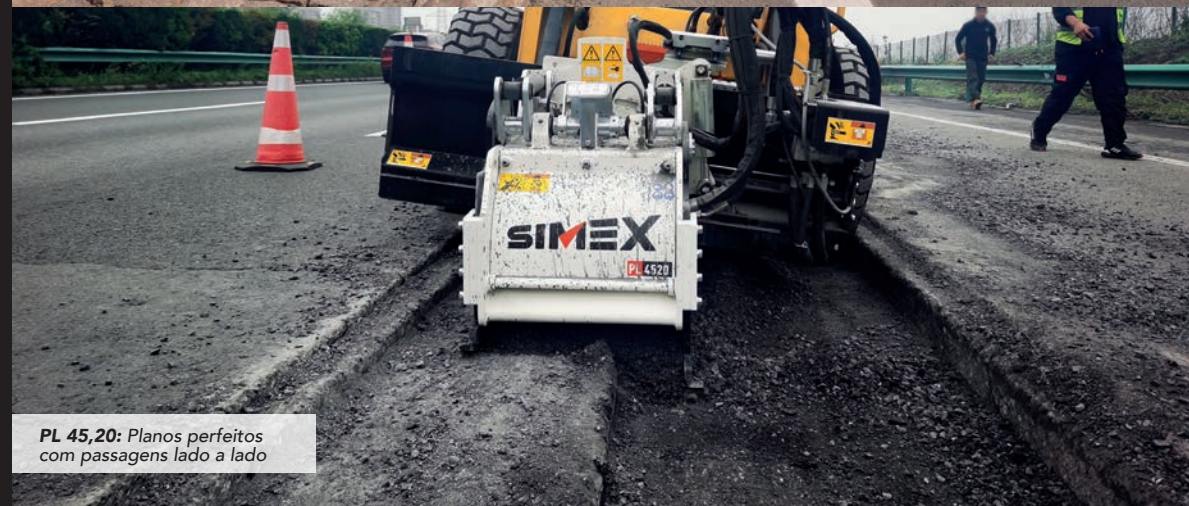
PL 45,20 HP: Reabilitação de uma estrada degradada.
