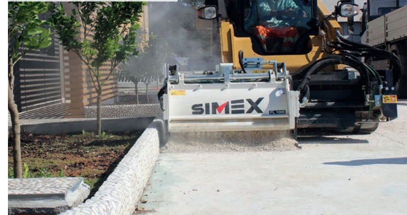
PL 1500. Escarificação com passagens lado a lado na repavimentação de uma berma portuária.
